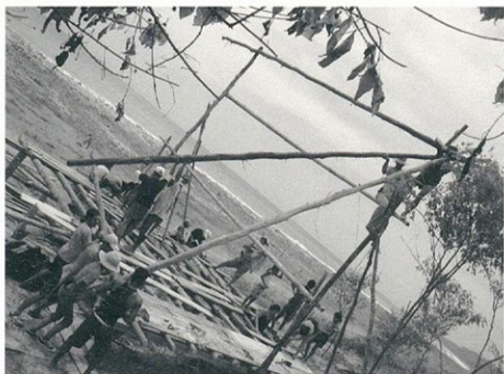
Levantamiento del primer módulo triangular. Detalle de un nudo en cuero. Acceso por la escalera. Estantería y diferentes momentos de la construcción. Erection of the first triangular module. Detail of a junction in leather. Access through the stairs. Shelf and different moments of the building process.
