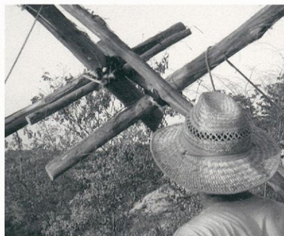
Levantamiento del primer módulo triangular. Detalle de un nudo en cuero. Acceso por la escalera. Estantería y diferentes momentos de la construcción. Erection of the first triangular module. Detail of a junction in leather. Access through the stairs. Shelf and different moments of the building process.
