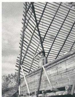
Levantamiento del primer módulo triangular. Detalle de un nudo en cuero. Acceso por la escalera. Estantería y diferentes momentos de la construcción. Erection of the first triangular module. Detail of a junction in leather. Access through the stairs. Shelf and different moments of the building process.
